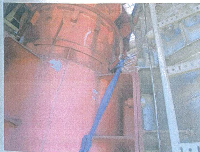
Fot. 10. Widok mocowania przewodu do rury nośnej (trzonu)
