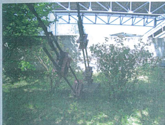
Fot. 14. Mocowanie odciągów w fundamencie
