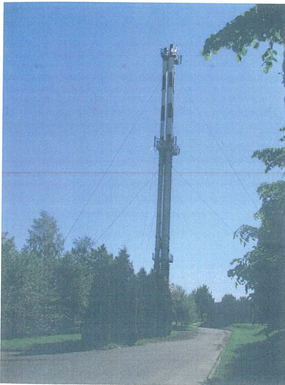
Fot. 1. Widok ogólny komina od strony zachodniej
