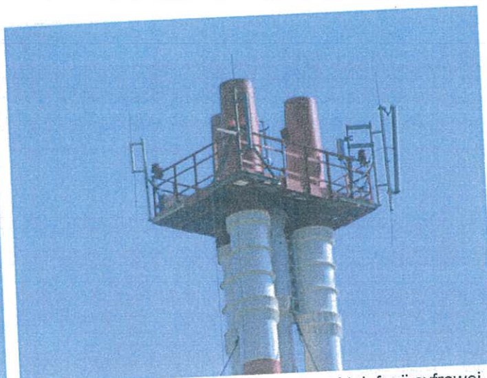
Fot. 2. Widok galerii górnej z antenami telefonii cyfrowej
