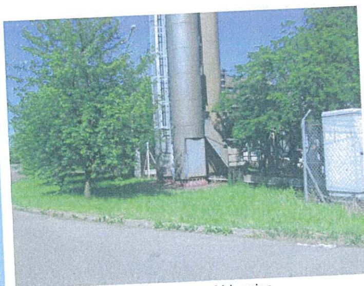
Fot. 5. Dolna część komina
