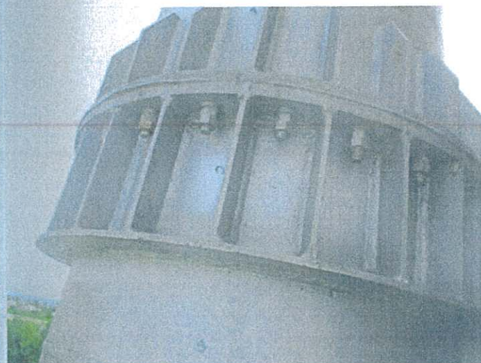
Fot. 8. Połączenie kołnierzowe segmentów kominia
