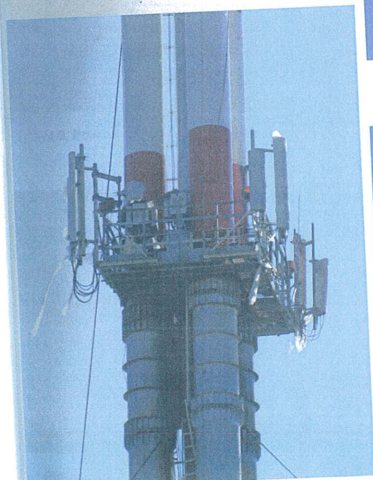
Fot. 3. Galeria środkowa z antenami telefonii cyfrowej
