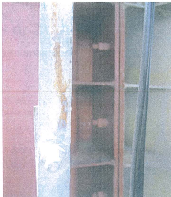
Fot. 15. Połączenie ramy z rurą nośną
