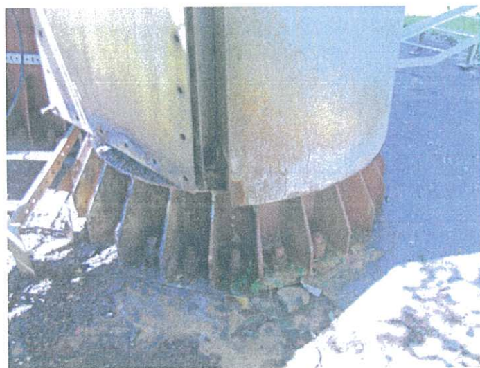
Fot. 11. Mocowanie jednego z przewodów do fundamentu
