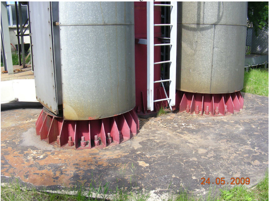
Fot. 2 Oparcie komina na fundamencie
