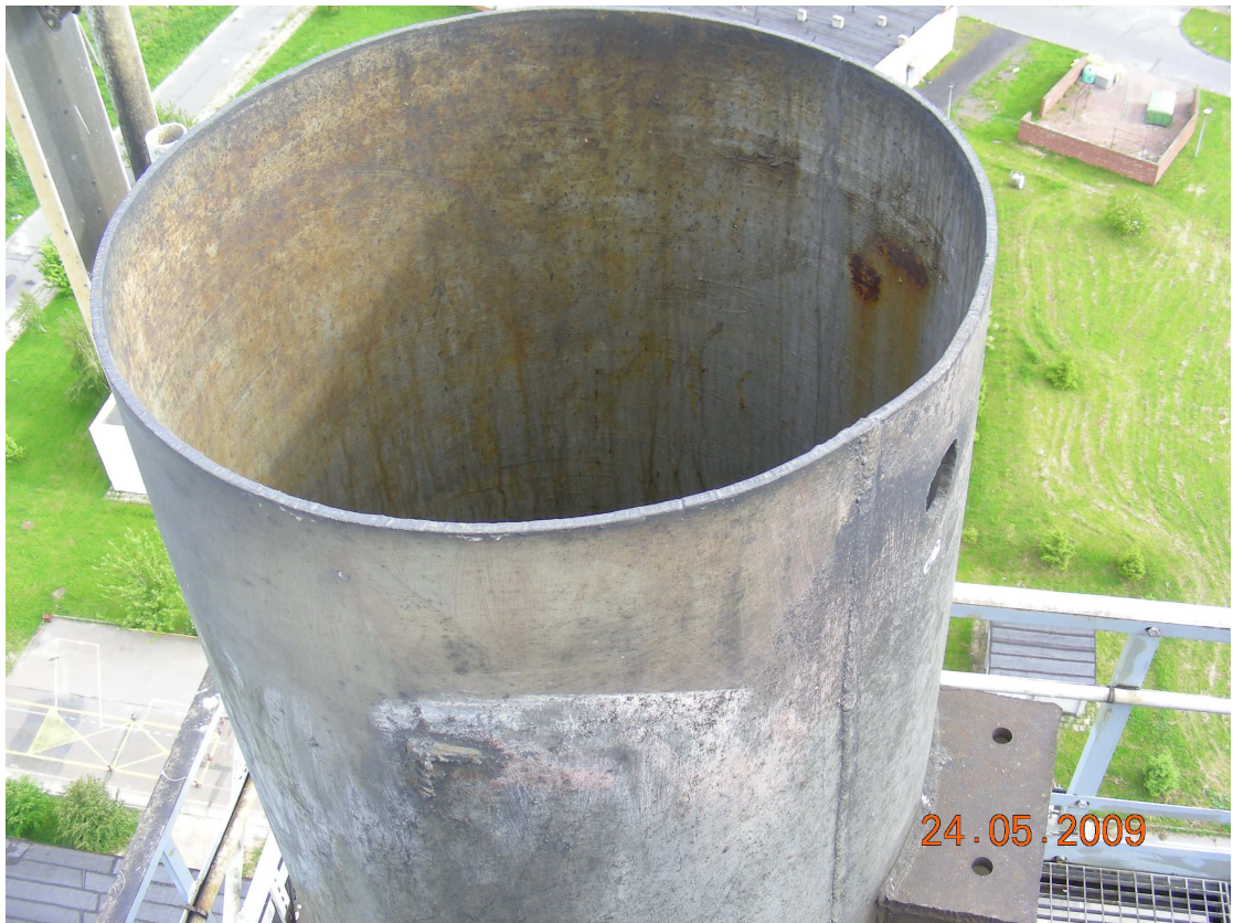
Fot. 5 Wylot przewodu rezerwowego nr 2.
