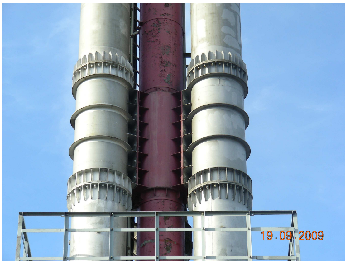
Fot. 3 Pomost, mocowanie przewodów komina do sztycy i stan jej powłoki malarskiej.
