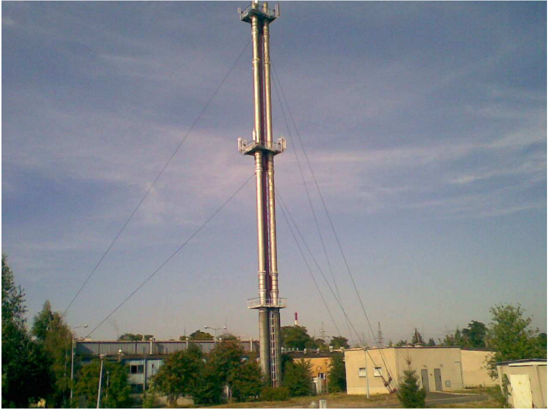
Fot. 1 Widok ogólny komina.
