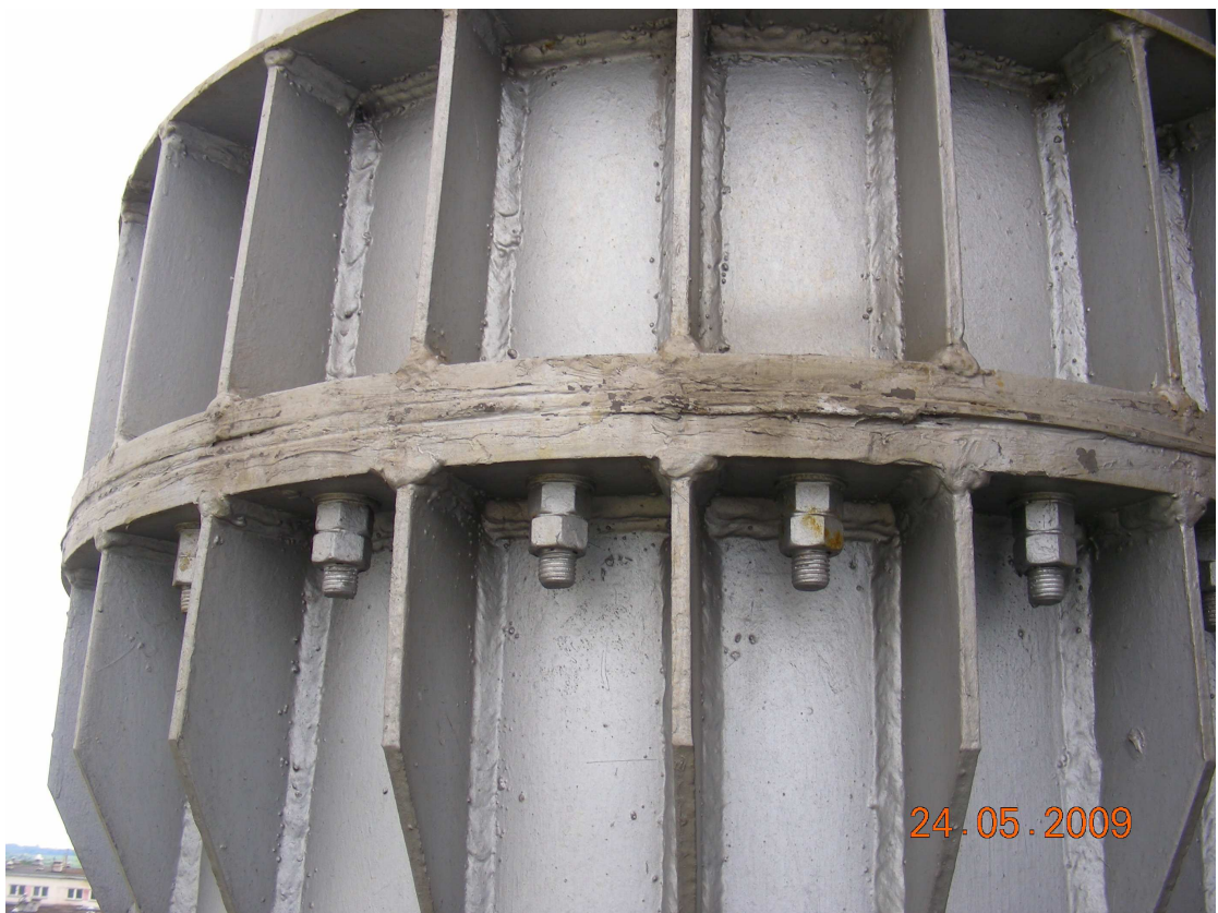
Fot. 8 Kołnierz komina rezerwowego bez korozji.
