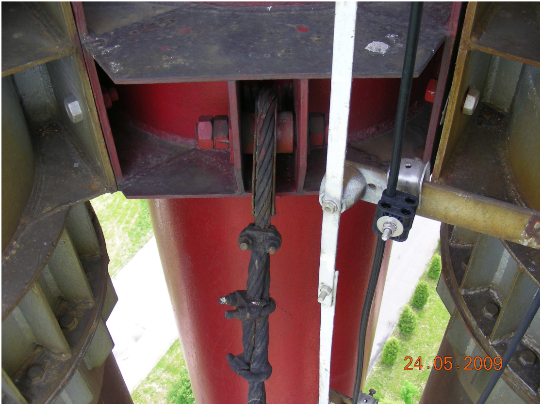
Fot. 11 Zamocowanie odciążu do sztycy komina.
