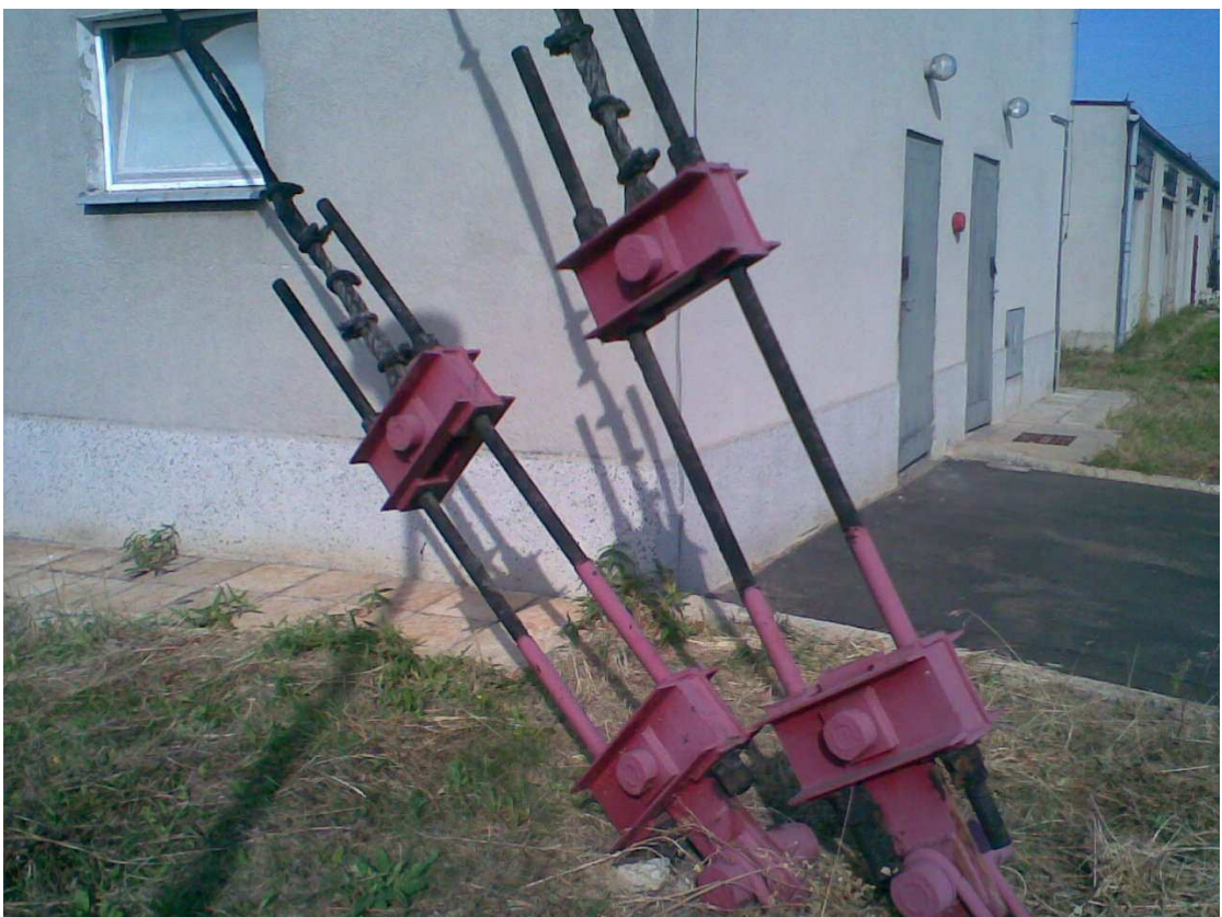
Fot. 12 Zamocowanie odciążów do bloku kotwiącego.
