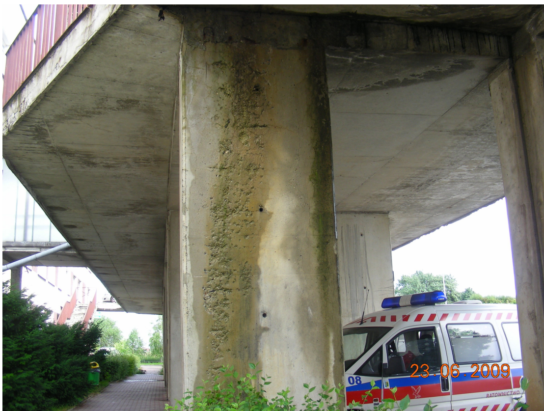
Fot. 10 Zniszczenie słupów od przecieków z dylatacji.
