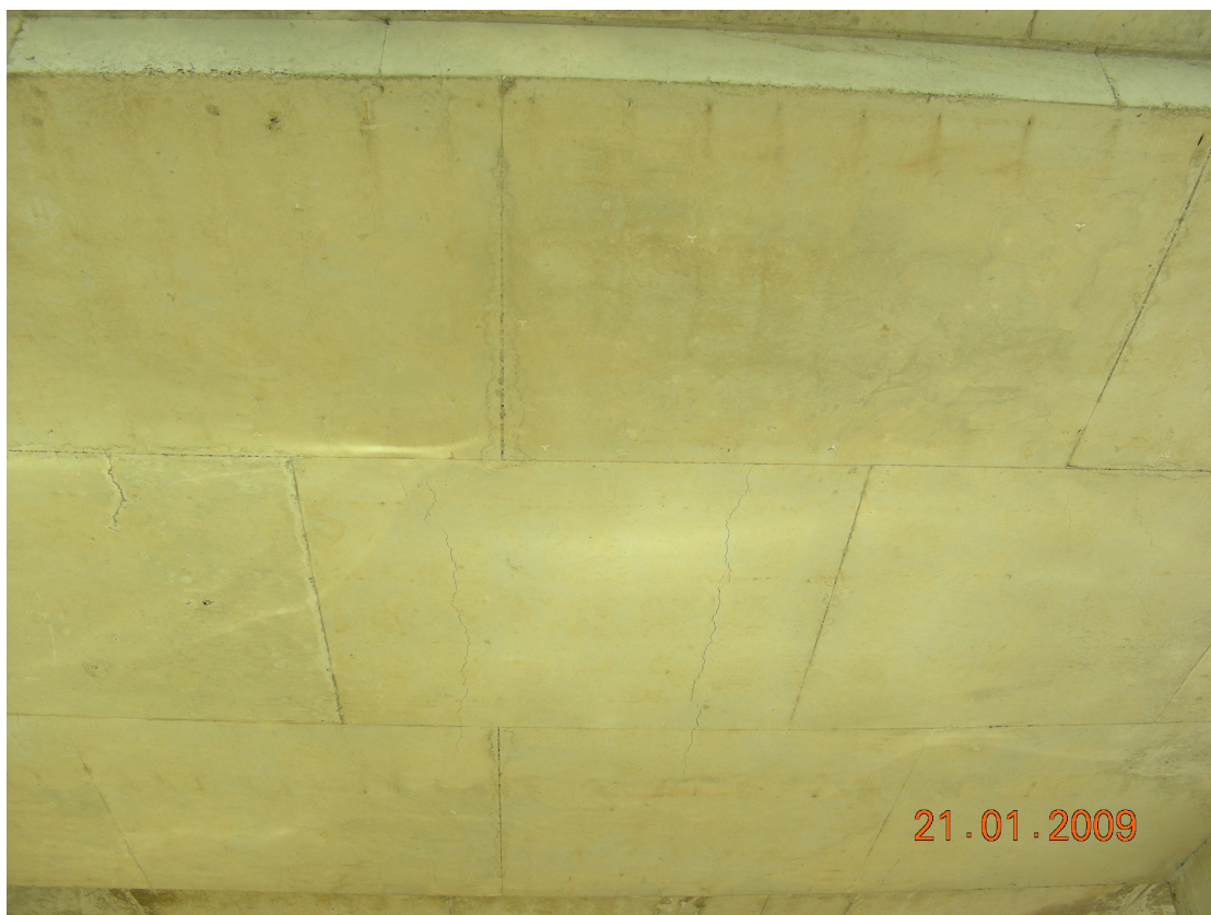
Fot. 4 Spękania i zarysowania betonu konstrukcji.
