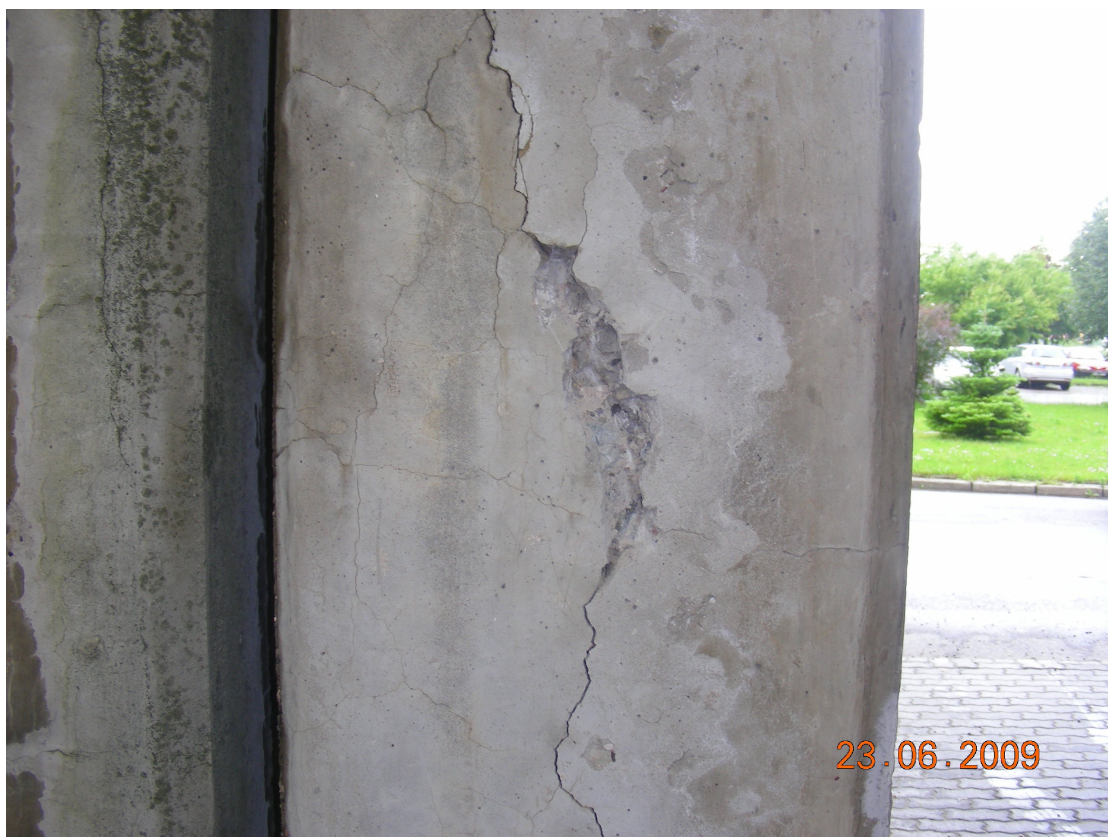
Fot. 7 Spękania słupów przydylatacyjnych..
