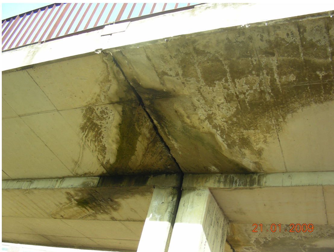
Fot. 4 Spękania i zarysowania betonu konstrukcji.
