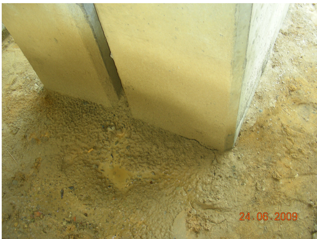
Fot. 10 Zniszczenie słupów od przecieków z dylatacji.
